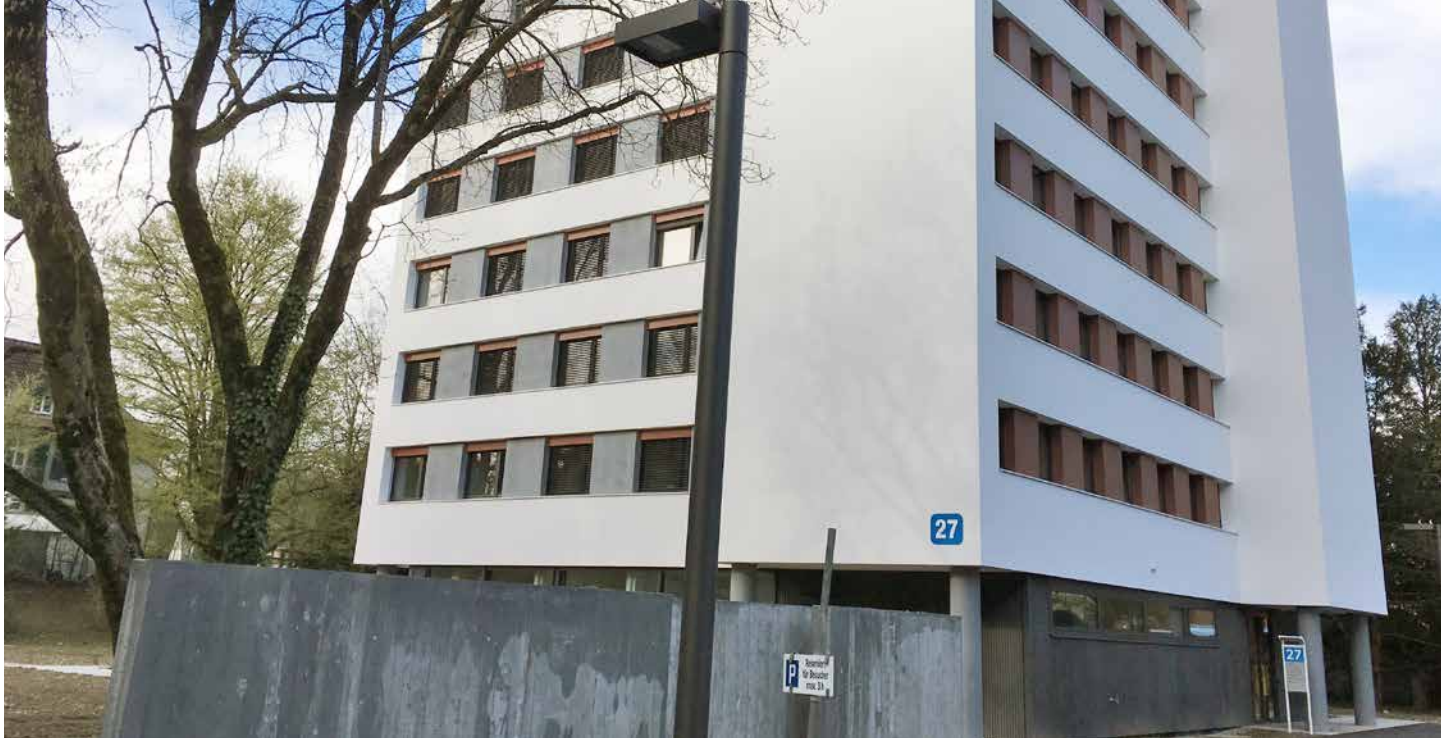
Vom Schwestern- zum Bürohaus: Aarau ältestes Hochhaus wurde totalsaniert.
